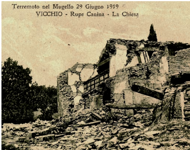
Danni prodotti dal terremoto del 1919 a Vicchio nel Mugello (FI).
