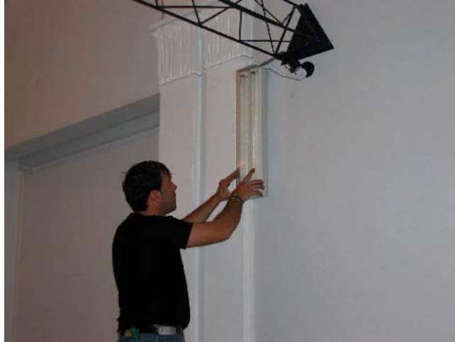
Fig 7. Installazione dell'impianto di illuminazione supplementare.
