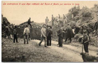
La costruzione di una diga contro del Duce d'Acate per deviare la lava.
