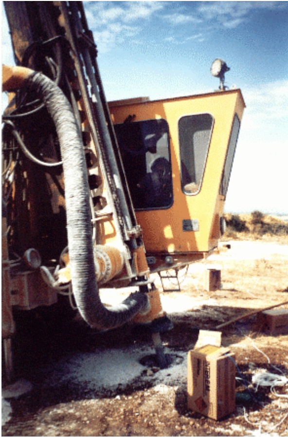
Fig.24 - La perforatrice scava uno dei pozzi lungo il fronte della cava
