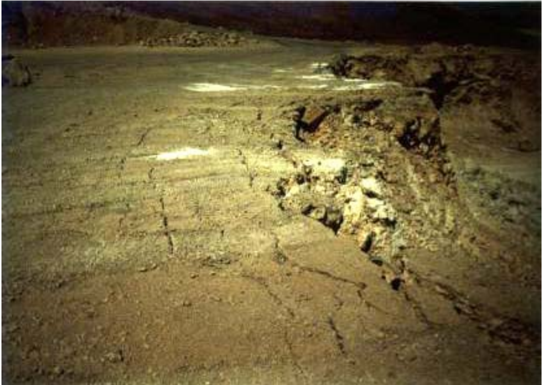
Fig.35 - Fratture del terreno parallele all'orlo del fronte abbattuto (franato a destra).
