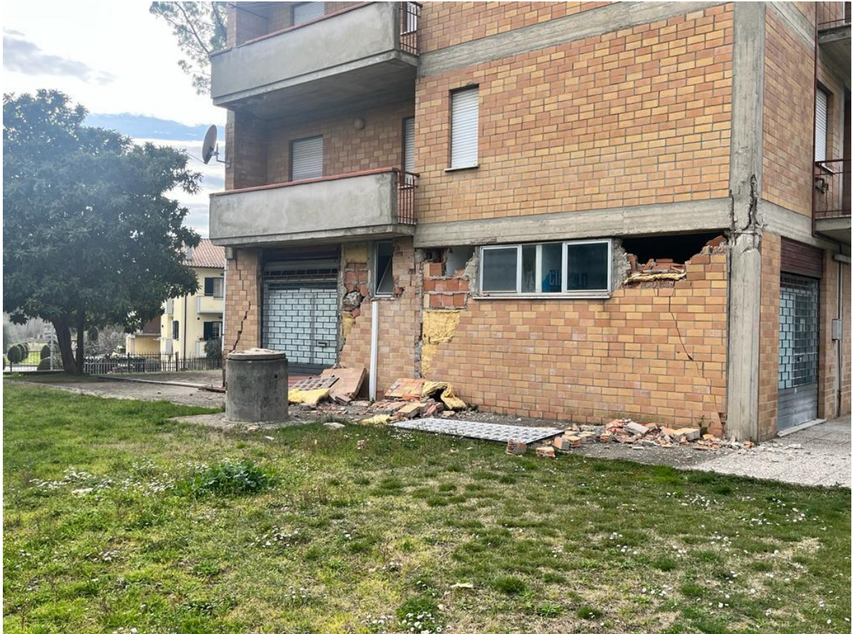
Fig. 8. Danno al pilastro e crollo parziale della tamponatura (grado 3) in un edificio in cemento armato a Sant'Orfeto.
