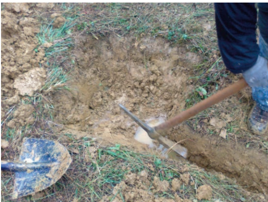
Figura 2 Operazioni di scavo inerenti al pozzetto da 40 cm del sensore.
