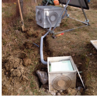
Figura 10 Stendimento del tubo corrugato per il passaggio dei cavi al sensore.
