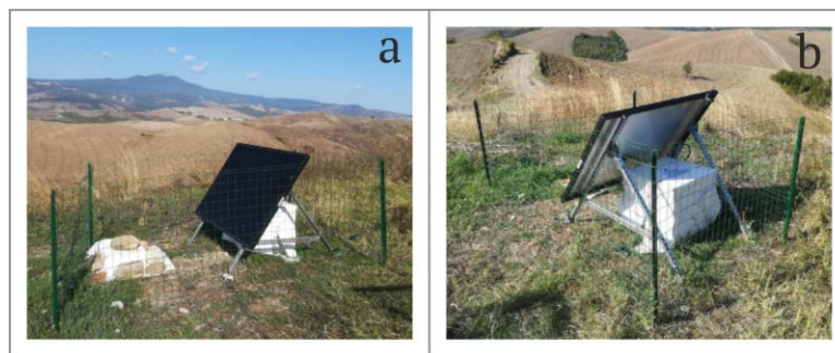
Figura 12 a,b) Stazione sismica CSC5 dopo il completamento dell'installazione. Figure 12 Final configuration of the CSC5 seismic station.
