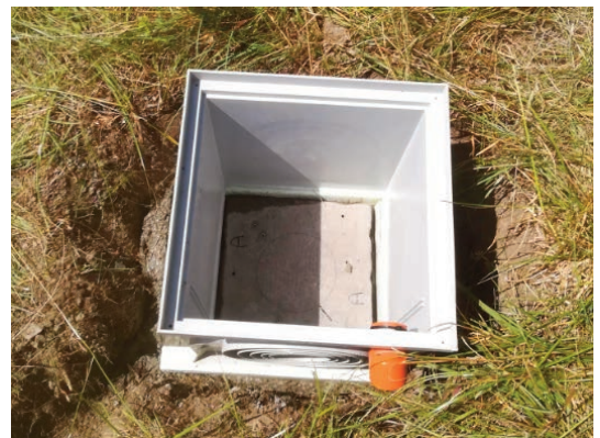
Figura 4 Pozzetto da 40 cm correttamente posizionato sulla cornice di polistirene.
