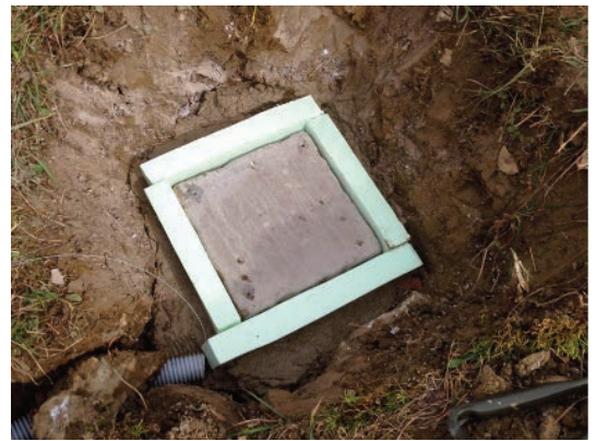
Figura 3 Posizionamento della mattonella 30x30cm alla base dello scavo.
