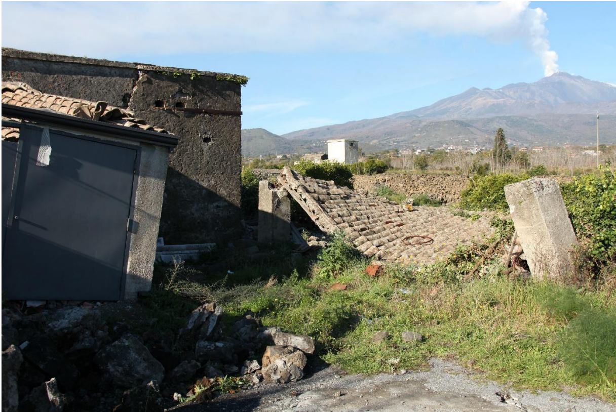
Figura 2 - Crollo di un fabbricato rurale nelle campagne di Acireale dovuto al terremoto del 26 dicembre 2018, che ha seguito di un paio di giorni l'eruzione sull'alto versante meridionale dell'Etna.
