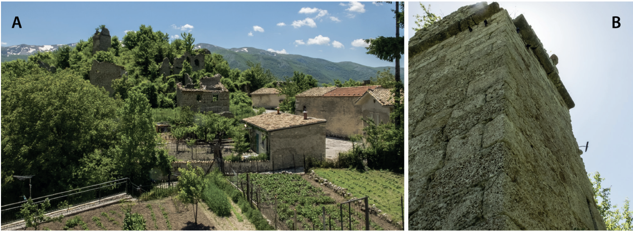
Fig. 3 - Frattura: insediamento originario. A) Edifici distribuiti sul modesto rilievo in condizioni ruderali e fabbricati con tracce di recente manutenzione nella sottostante zona pianeggiante, frequentata soprattutto per la coltivazione orticola. B) Chiesa di San Nicola, resti della torre campanaria; si noti sulla destra il tirante metallico e il capochiave emergenti dalla muratura e sospesi nel vuoto.
