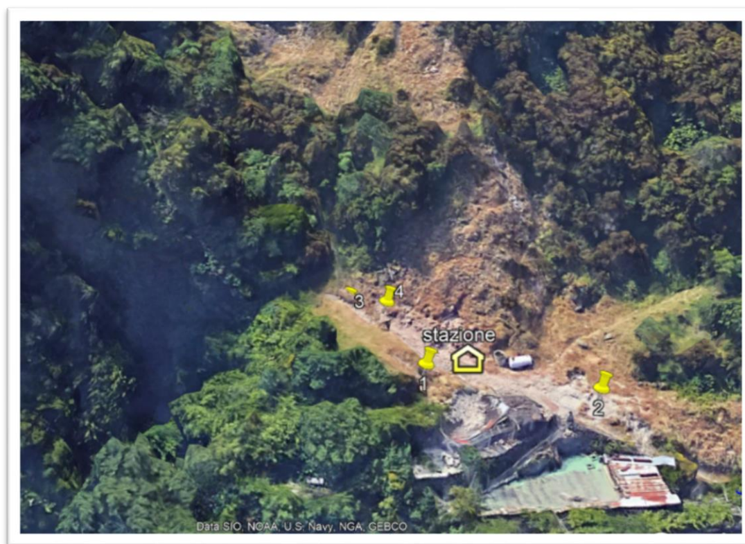
Figura 4.2.2 - Ubicazione in località Pizzone Mt. Cito della stazione e dei punti di misura della temperatura.
