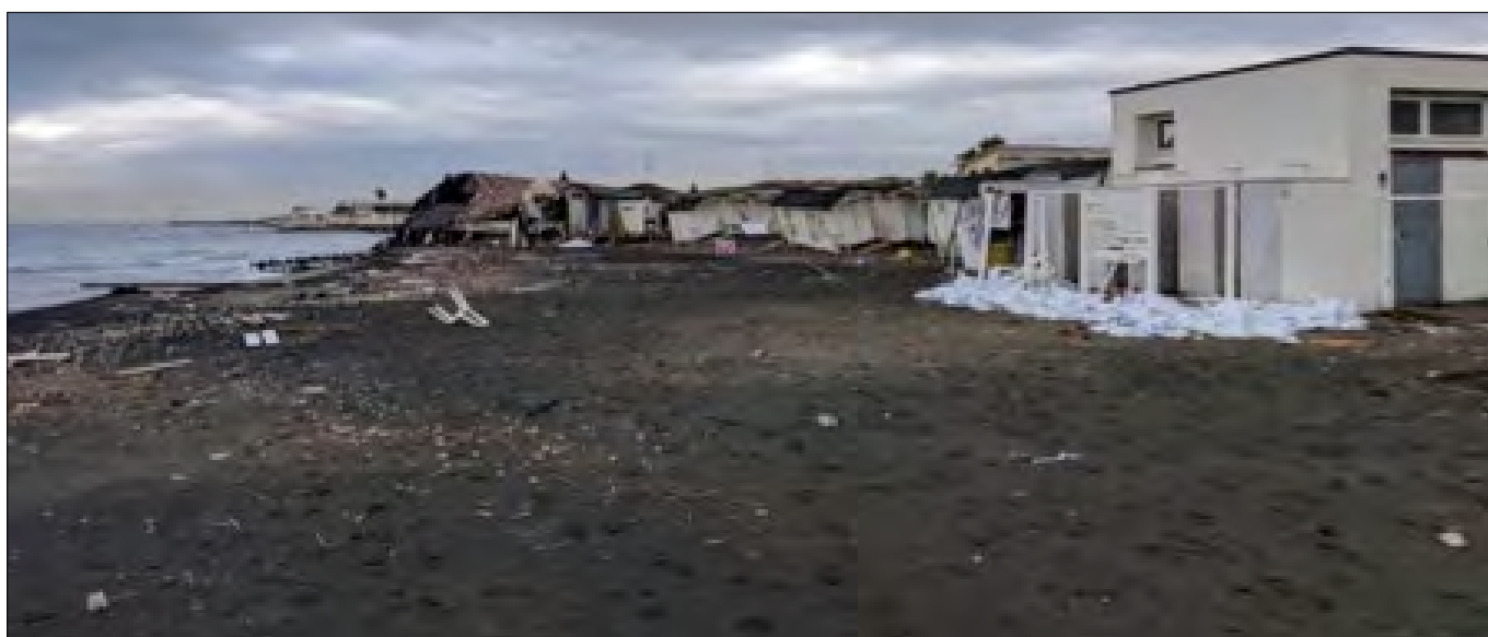
Figura 4. Lo stabilimento Vecchia Pineta ed i danni prodotti dall'erosione allo stabilimento Nuova Pineta (Foto 2019)
