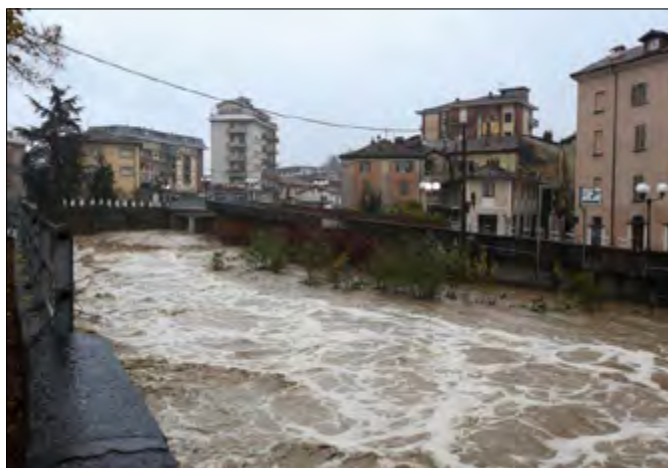
Figura 13. Evento alluvionale del 21-25 novembre 2016: in corrispondenza della sezione C1, le impetuose acque del T. Cevetta sono fortunatamente rimaste al di sotto anche degli argini naturali (RIF. WEB n. 2)
