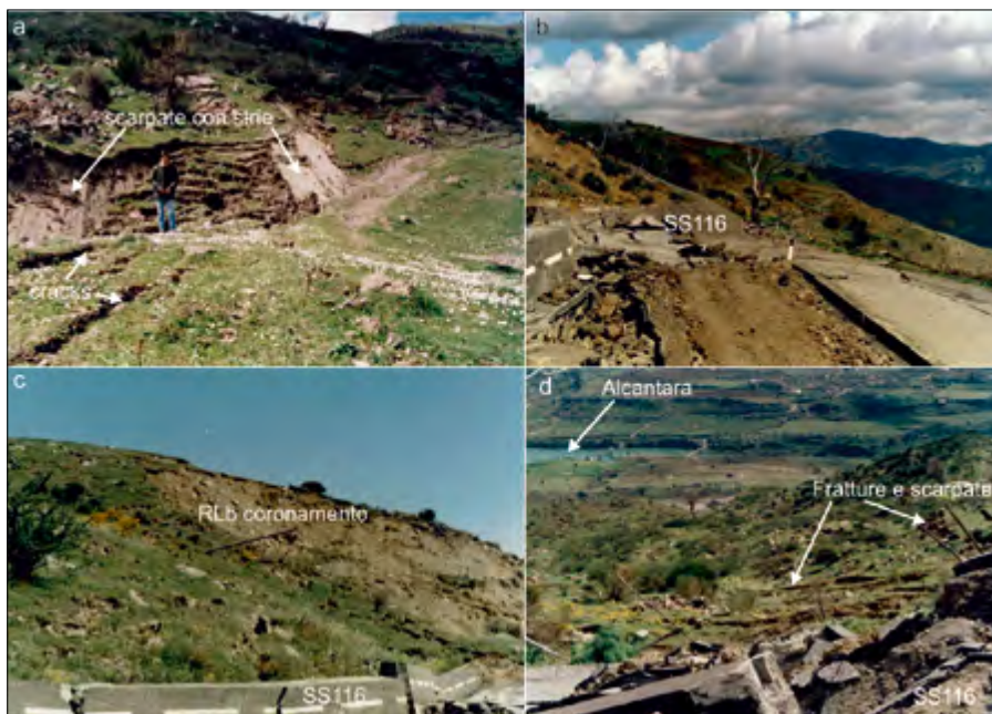
Figura 3. Foto del 1996: a) scarpate a monte del coronamento; b) SS 116 coinvolta nel movimento; c) coronamento; d) vista panoramica da monte (modificato da Pappalardo et al., 2018)
