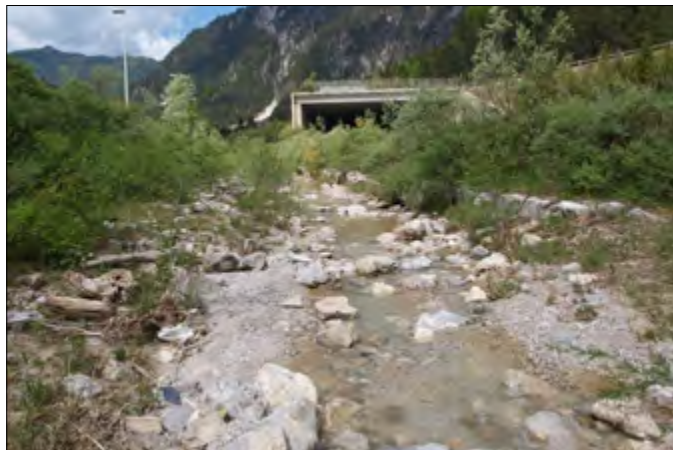
Fiume Fella, post operam, maggio 2011
