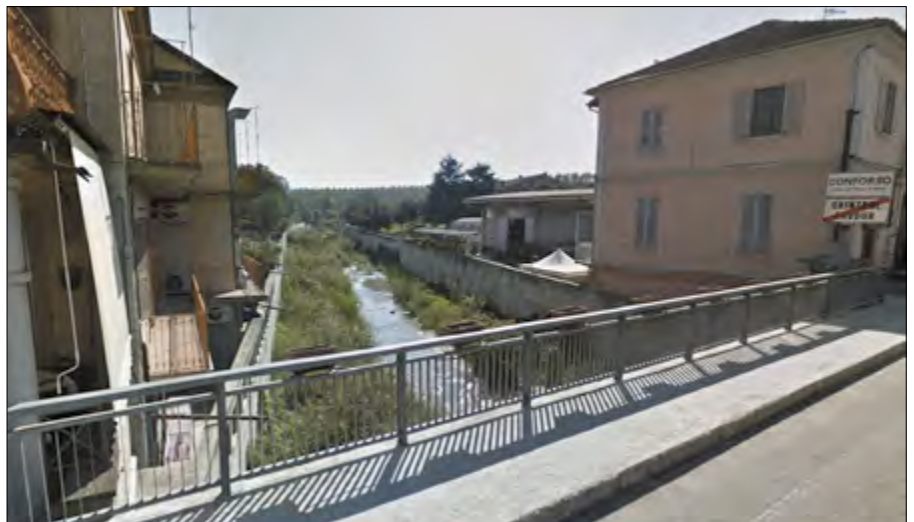
Figura 6. Ubicazione della sezione 1, immediatamente a monte del ponte sul T. Talloria di Sinio, posto al confine tra il comune di Grinzane Cavour e quello di Diano D'Alba: le case si trovano addossate al corso d'acqua
