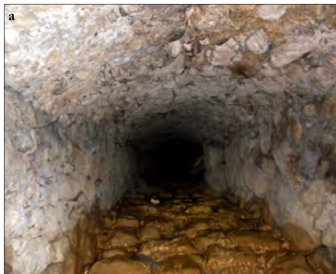
Figura 3. Sezioni minime ad arco (a) e rettangolari della condotta (3b)
