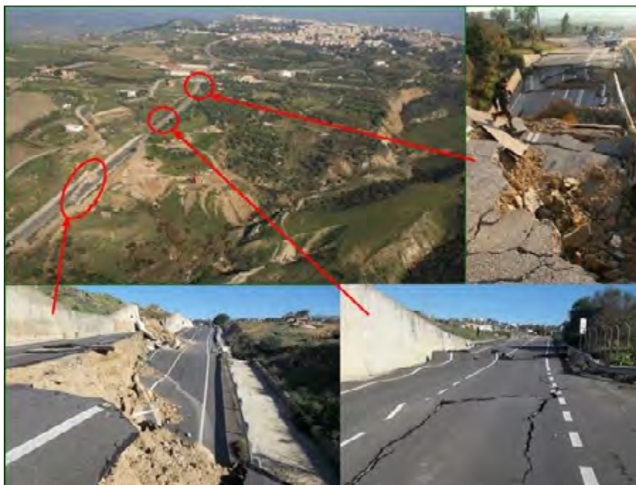
Figura 2. Foto aerea della frana e danni alla strada di collegamento dell'abitato di Montescaglioso con la strada statale di fondovalle
