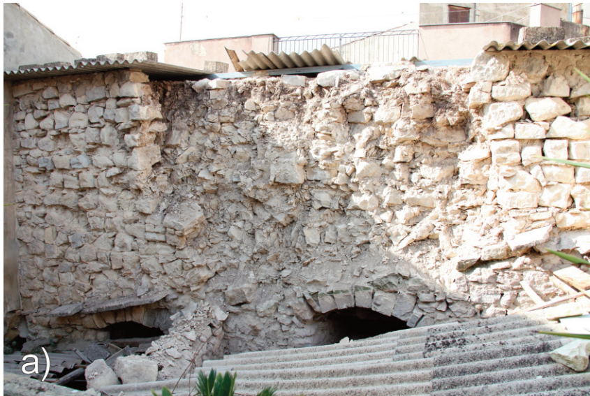
Foto 10 a) Giarratana: crollo parziale di un muro perimetrale “a sacco” di un vecchio edificio abbandonato (cl. A), alle spalle della chiesa madre; b) San Giacomo: lesione e distacco tra le travi di un edificio in c.a. (cl. C) adibito a capannone commerciale.
