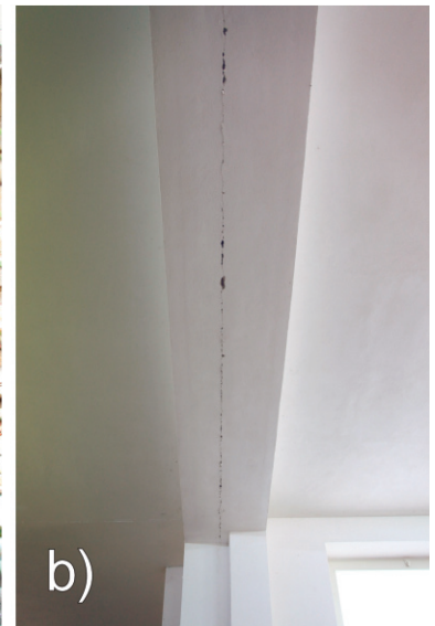
Foto 10 a) Giarratana: crollo parziale di un muro perimetrale “a sacco” di un vecchio edificio abbandonato (cl. A), alle spalle della chiesa madre; b) San Giacomo: lesione e distacco tra le travi di un edificio in c.a. (cl. C) adibito a capannone commerciale.
