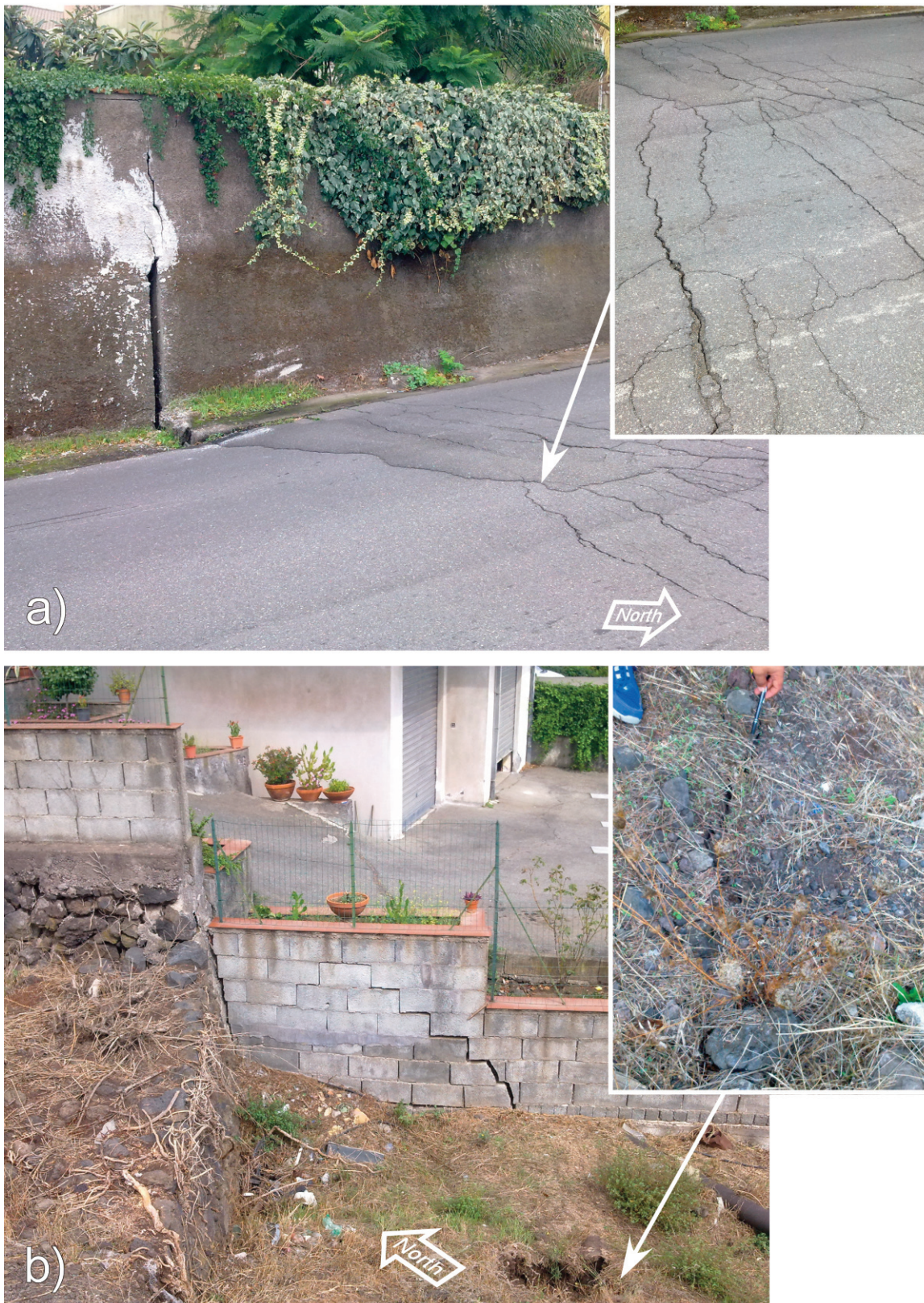
Foto 2 S. Maria la Stella: a) la fagliazione cosismica attraversa la via Florida, sovrapponendosi al campo di fratture preesistenti dovute a creep asismico; b) 20 m più a nord, la fagliazione è ben visibile anche su suolo agrario prima di attraversare il muretto e l'edificio retrostante.
