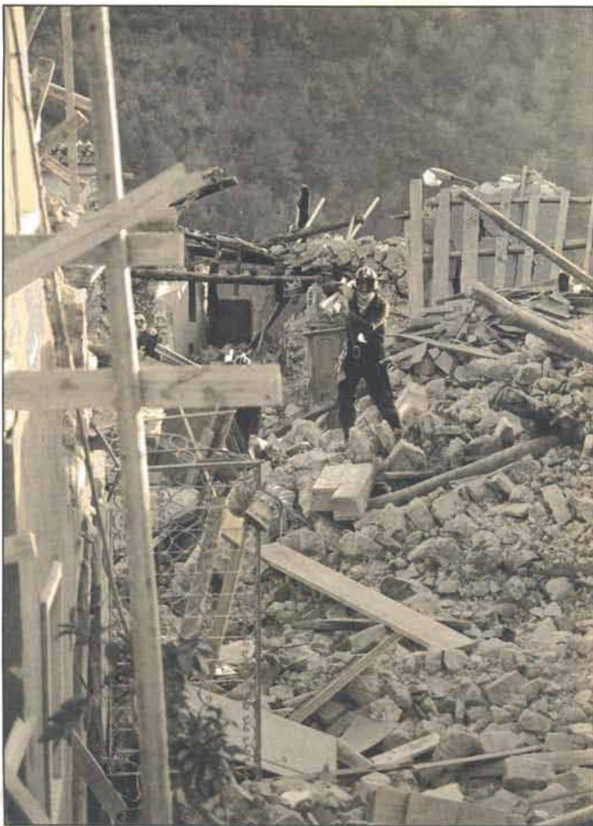
▲ Trasporto di attrezzi per la rimozione delle macerie nel comune di S. Mango sul Calore
