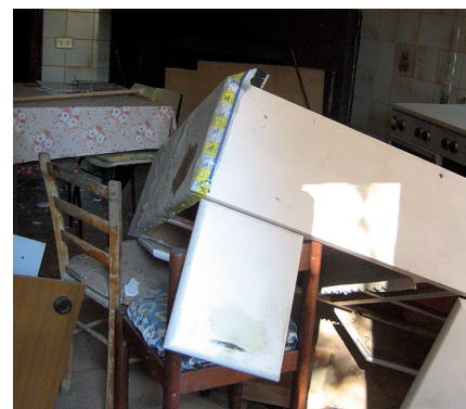
Interno di una cucina dopo il terremoto di Amatrice del 24 Agosto 2016, Magnitudo=6.0 . mobili si sono staccati dal muro.
