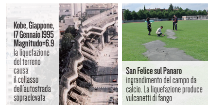
San Felice sul Panaro, in Emilia dopo il terremoto del 2012, Magnitudo= 6.1. Le macchie grigie nel prato del campo da calcio sono tracce di liquefazione
