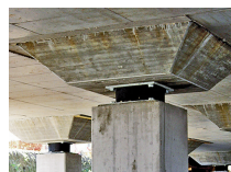
Gli isolatori (in nero) sono posti al di sotto dell'edificio. I movimenti orizzontali del terreno non si trasmettono all'edificio
