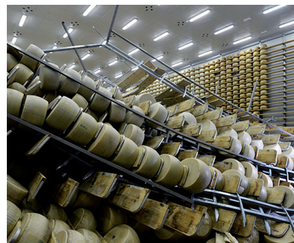
La libreria ribaltandosi ha bloccato l'uscita. Il terremoto del 20 maggio 2012, Magnitudo=6.1 , che ha colpito l'Emilia ha prodotto molti danni nei magazzini che contenevano il Parmigiano Reggiano. Circa 100.000 forme di formaggio sono cadute o rimaste incastrate tra i ferri e macerie, da dover richiedere l'intervento dei Vigili del Fuoco.
