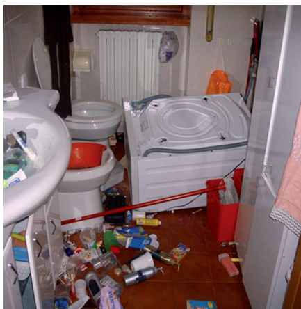
Interno di una bagno dopo il terremoto di L'Aquila del 6 Aprile 2009, Magnitudo=6.3 . L'azione sismica è stata tale da produrre il ribaltamento della lavatrice.
