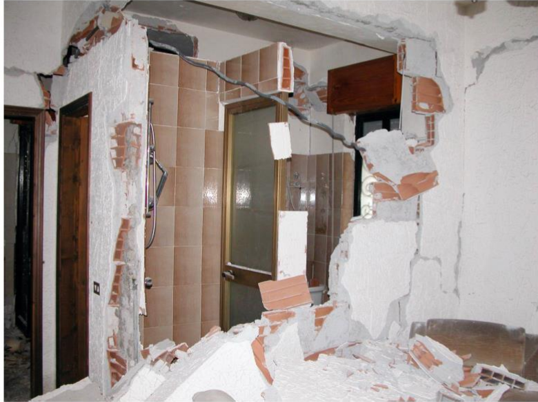
Crollo di un tramezzo all'interno di un edificio in cemento armato
