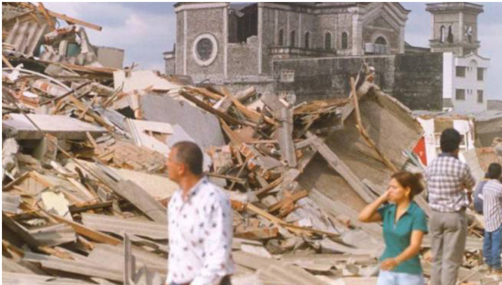
Figura 10. El evento del 25 de enero del 1999 conocido como el terremoto de Armenia. a) Puntos de intensidad macrosísmica del SGC (2013), se observa que la intensidad en Armenia es 9(EMS98). b) Fotografía del evento en la ciudad de Armenia. (Fuente: http://caracol.com.co/emisora/2016/01/25/armenia/1453727445_582883.html ).
