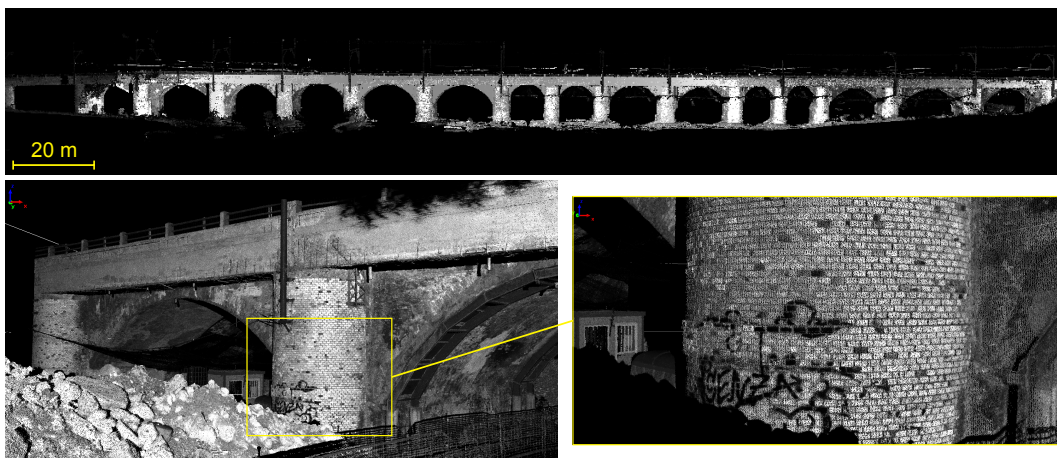
Figura 10. L'insieme completo delle nuvole di punti, allineate tra loro, a ricostruire l'intero prospetto sud del ponte. Sotto, la prima scansione effettuata ed una zoomata che mostra il dettaglio raggiunto. Complessivamente, l'area rilevata ha una lunghezza di circa 260 m.
