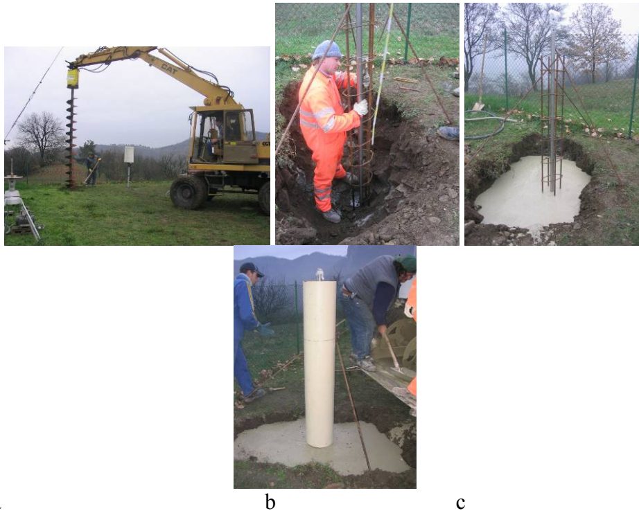
Figura 14 - Alcune fasi costruttive della stazione GPS di Teolo: a) trivellazione per fondazione; b) collocazione dei ferri; c) gettata in cemento per fondazione; d) ultimazione del pilastro
