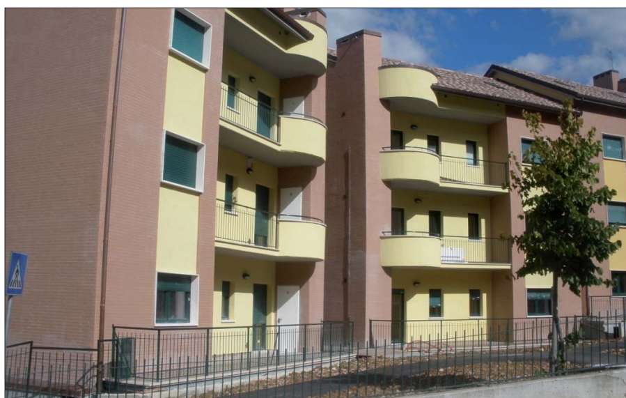
Figura 4 – (a – in alto a sinistra) Villa in c.a. di 3 piani e mansarda a L'Aquila (SS 17), fortemente danneggiata dal sisma del 2009, rinforzata con il Metodo CAM ed adeguata con 8 HDRB e 19 SD (foto a sinistra, del P.I. B. Spadoni); (b – a destra e in basso a sinistra) retrofit con l'isolamento sismico del complesso edilizio residenziale di via dei Tigli di Pianola (AQ) (42 HDRB e 62 SD, progetto dei soci GLIS Ingg. G. Mancinelli e D. Corsetti, collaudo statico in c.o. dello scrivente, in maggio 2014)
