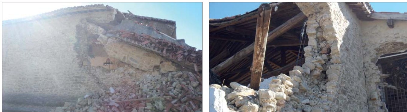
Figura 12 – Chiesa di San Martino: muratura pareti (a) lato sinistro (b) lato destro
