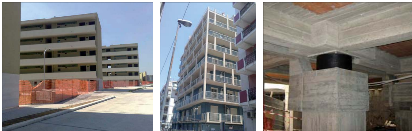
Figura 3 – (a – a sinistra) Tre dei quattro edifici residenziali di 5 piani di Cerignola (FG), isolati mediante 124 HDRB, con costi aggiuntivi di costruzione nulli rispetto ad edifici fondati convenzionalmente (prima applicazione dell'isolamento nell'ambito nei cosiddetti "Contratti di Quartiere"), progettati dal socio GLIS ed ASSISi Ing. A. Dusi ed altri e collaudati in c.o. dallo scrivente nel 2009; (b – al centro e a destra) il nuovo edificio residenziale di Via Spadafora a Messina, di 8 piani (oltre al cantinato) costruito (dopo la demolizione di quello precedente) su 11 LRB e 2 SD installati alla sommità dei pilastri del garage interrato, progettato dal membro del Consiglio Direttivo GLIS e socio ASSISi Ing. M. Marino e collaudato in c.o. dallo scrivente e dall'Ing. G. Camiti di Messina nel 2014 (previa installazione di un sistema che garantisca l'integrità del giunto strutturale pure nel caso di eventuali crolli dell'edificio convenzionale adiacente)
