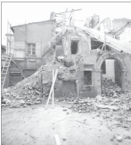
Figura 11 – Terremoto del 23 novembre 1980: crollo del Palazzo Bollettino nella città di Potenza (Fonte: Soprintendenza Archeologia, Belle Arti e Paesaggio della Basilicata, Potenza)
