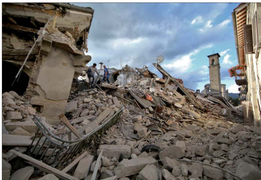
Figura 7 – Il centro storico di Amatrice, dopo il terremoto del 24 agosto 2016
