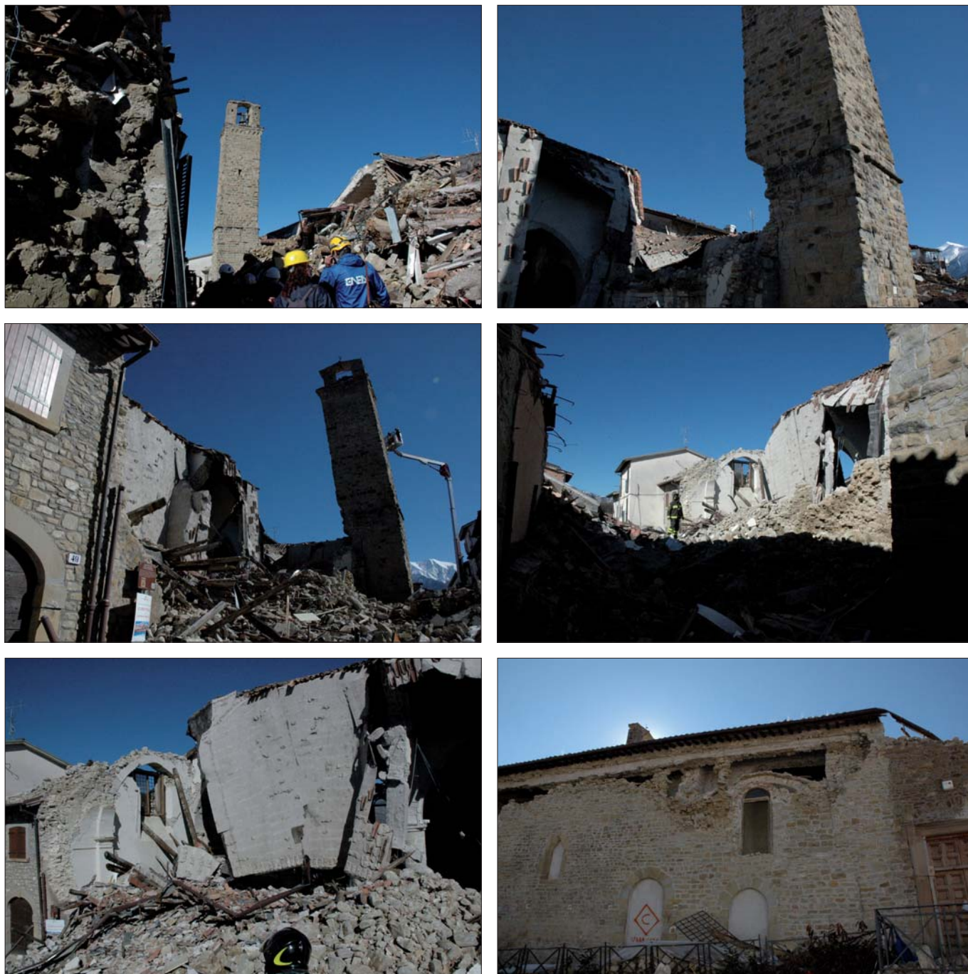
Figura 9 – Chiesa di S. Emidio. Crollo della chiesa e grave danneggiamento del campanile
