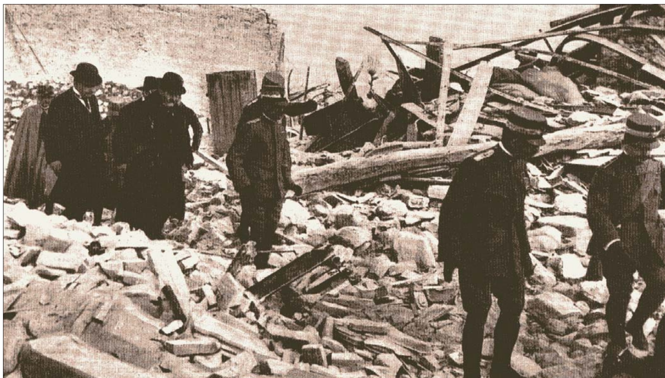
Figura 5 – Fotografia del terremoto di Avezzano (1915)
