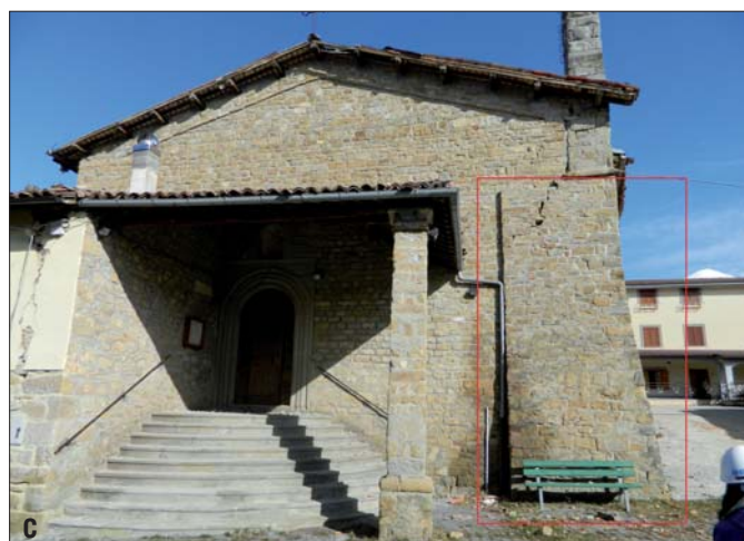
Figura 20 – Chiesa Madonna della Torre: (a) meccanismo di ribaltamento della facciata contrastato da (b) un edificio addossato e (c) un contrafforte
