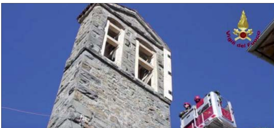
Figura 8 – Chiesa di S. Clemente. Messa in sicurezza del campanile a settembre 2016 (VIGILI DEL FUOCO, 2016)
