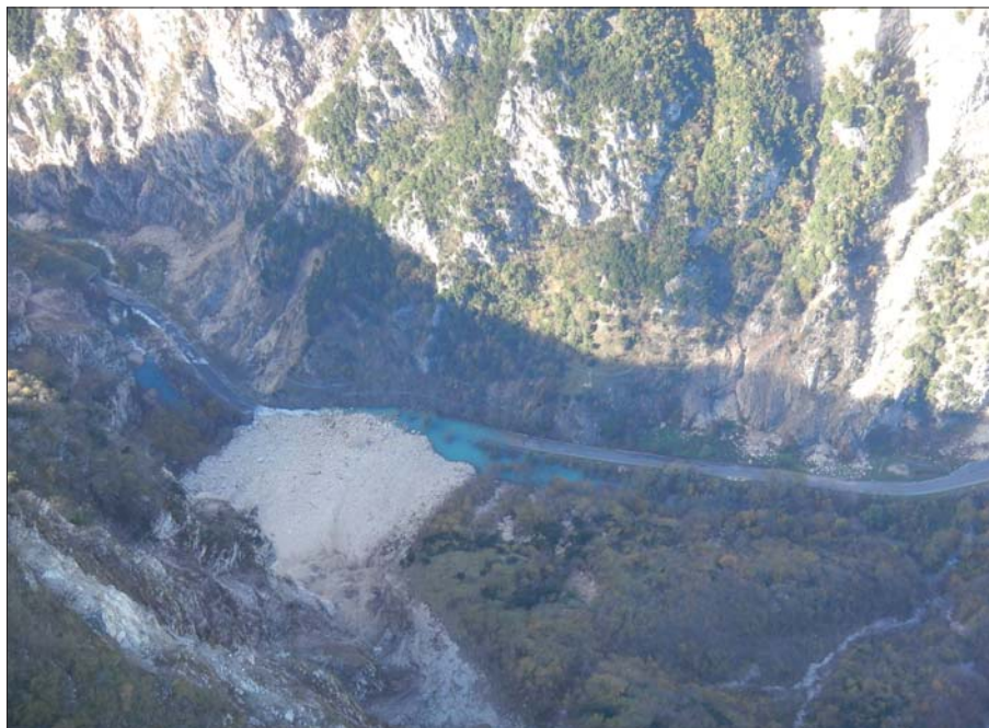
Figura 17 – Frana sulla SS 209 tra Visso e Saccovesio Il franamento di una massa di roccia fratturata e detriti (volume stimabile intorno a diverse migliaia di mc) ha ostruito il corso del Fiume Nera posizionato alcuni metri al di sotto del piano stradale e parte della strada stessa. Le acque del fiume, deviate dalla frana, hanno creato un laghetto a monte dell'accumulo invadendo la sede stradale
