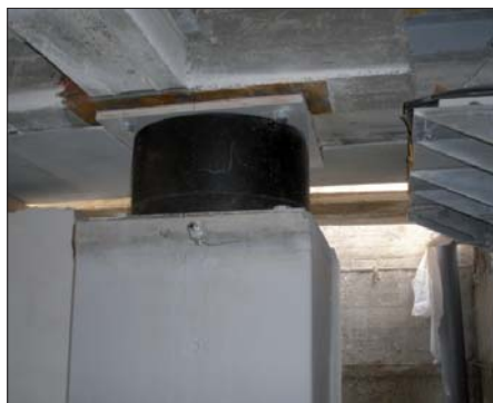
Figura 4 – (a – in alto a sinistra) Villa in c.a. di 3 piani e mansarda a L'Aquila (SS 17), fortemente danneggiata dal sisma del 2009, rinforzata con il Metodo CAM ed adeguata con 8 HDRB e 19 SD (foto a sinistra, del P.I. B. Spadoni); (b – a destra e in basso a sinistra) retrofit con l'isolamento sismico del complesso edilizio residenziale di via dei Tigli di Pianola (AQ) (42 HDRB e 62 SD, progetto dei soci GLIS Ingg. G. Mancinelli e D. Corsetti, collaudo statico in c.o. dello scrivente, in maggio 2014)
