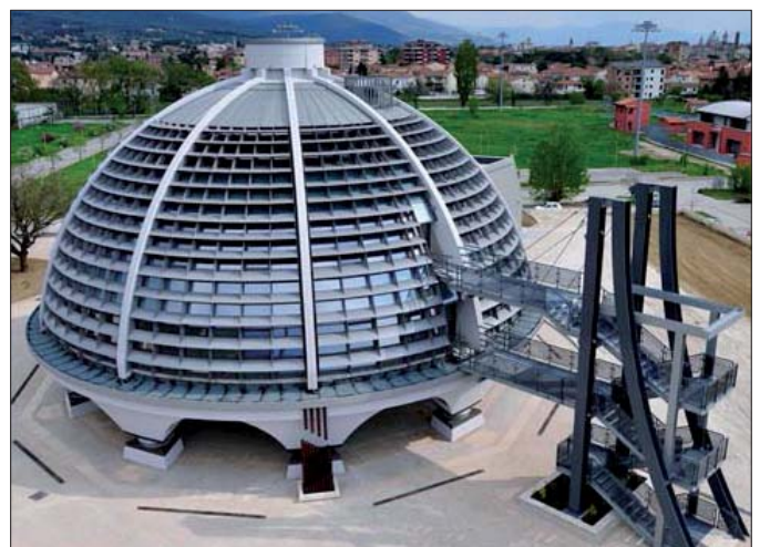
Figura 2 – L'edificio principale ("Sale Operative") del Centro della Protezione Civile di Foligno (ove sono numerosi gli edifici isolati), che poggia su 10 HDRB di 1 metro di diametro (il corpo centrale, contenente le scale di accesso, è sospeso e giuntato), progettato dal socio GLIS ed ASSISI Prof. A. Parducci (con la collaborazione dell'ENEA per la ridefinizione delle azioni sismiche di progetto) e collaudato in c.o. dallo scrivente nel 2011 (si notino l'architettura, impossibile con fondazioni convenzionali e per la quale il Prof. Parducci ha ottenuto premi, ed il fatto che l'edificio è stato dotato di un sistema di monitoraggio sismico, come raccomandato dallo scrivente nella sua relazione di collaudo, realizzato con la collaborazione dell'ENEA e che ha permesso l'ottenimento di dati di estrema importanza durante la crisi sismica iniziata il 24 agosto 2016 nell'Italia Centrale)
