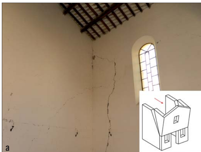
Figura 20 – Chiesa Madonna della Torre: (a) meccanismo di ribaltamento della facciata contrastato da (b) un edificio addossato e (c) un contrafforte
