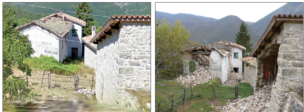
Figura 2 Edificio non ristrutturato dopo il 1997: a sinistra, immagine da Google Street View (2011); a destra, immagine dopo il 30 ottobre 2016 (Gualdo, frazione di Castel Sant'Angelo sul Nera).
