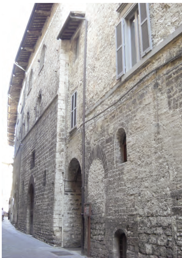
Figura 12 Gubbio, Via Cavour, imbocco di Via Toschi Mosca: arco di rinforzo costruito dopo il terremoto del 1751 tra i palazzi Bentivogli e Beni (foto di E. A. Sannipoli).
