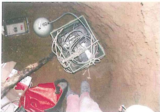
Figura 3: il sismometro alla base del pozzo della CA 270 La RM durante l'installazione temporanea. Sulla destra della foto si nota la parete laterale del pozzo (foto C. Galeazzi). Figure 3: seismometer on the bottom of CA 270 La RM pothole during a temporary deployment. On the right side of the image the lateral wall of the pothole is visible. (photo C. Galeazzi).
