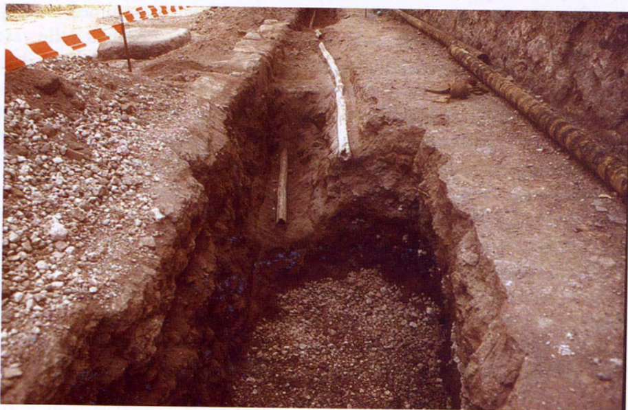
Fig. 3 - Fistulae in fase di smontaggio lungo Via di Nola
