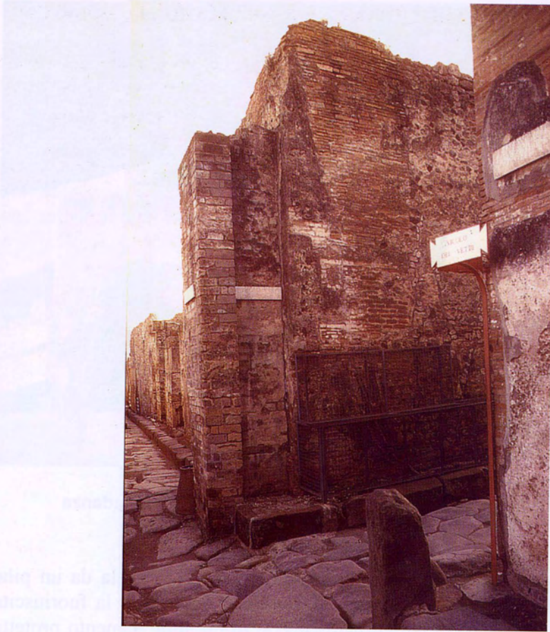
Fig. 2 - Castellum plumbeum nell'angolo Nord-orientale dell'Insula IV-13
