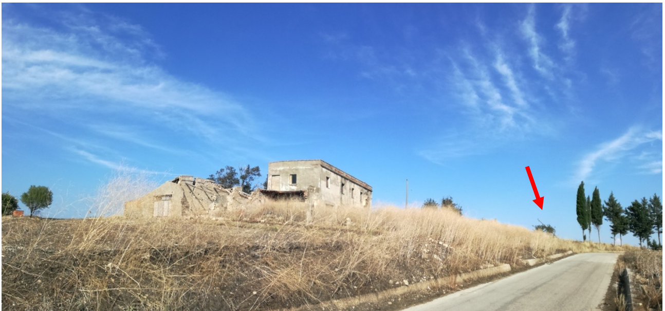
Foto 5: Strada Statale SS483 dove è visibile il palo della luce inclinato (freccia rossa).
