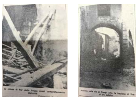
Figura 33 Immagini dei gravi danni in due frazioni di Norcia: a sinistra le macerie della chiesa di Pie' la Rocca; a destra i danni a Campi Alto, località interessata già da anni da una rovinosa frana [La Nazione, edizione Umbria, 1971.10.06].
