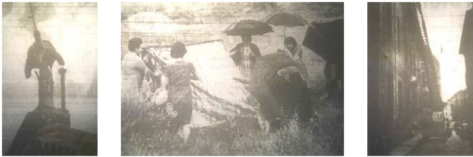
Figura 29 Da sinistra: la guglia pericolante della chiesa di S. Savino a Faenza, attendamenti provvisori e rimozione di tegole e camini pericolanti a Forlì [Il Resto del Carlino, 1963.08.10].
