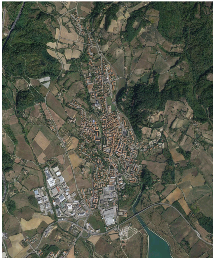
Veduta da satellite dell'abitato di Barberino di Mugello (FI), il più danneggiato dal terremoto del 9 dicembre 2019
